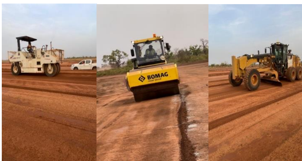
Figure 27: compactage et nivellement de la couche de forme après malaxage
