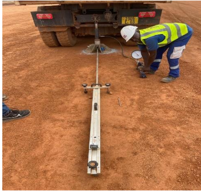
Figure 29: Réalisation de l'essai de portance sur le sol-ciment
