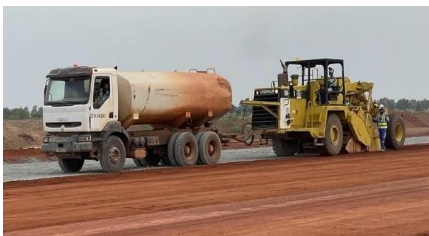
Figure 26: malaxage du matériau à l'aide de la recycleuse connectée à un camion-citerne
