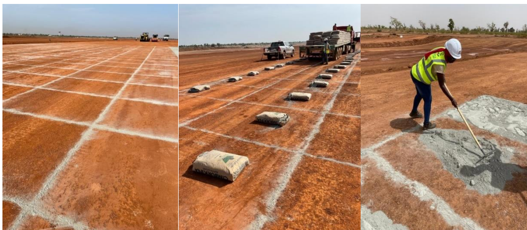
Figure 25: Illustration du traçage des mailles pour le dosage en ciment et étalage du ciment
