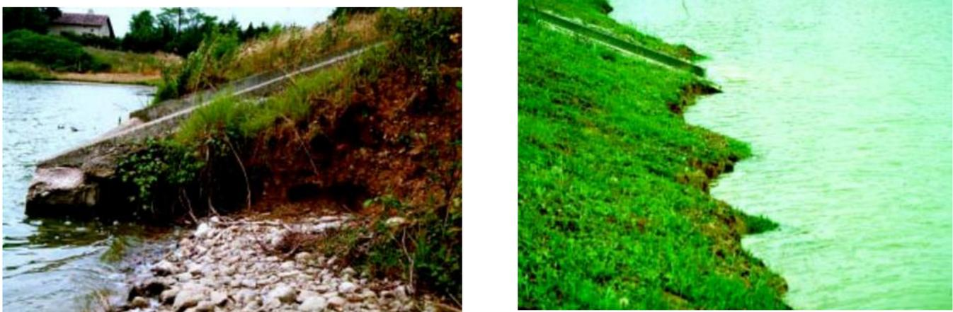
Figure 5 : a) Batillage au voisinage du deversoir du barrage de LAUNAC(1998) b) Talus enherbé marqué par le batillage au niveau de la retenue normale (Lautrin, 2002)
