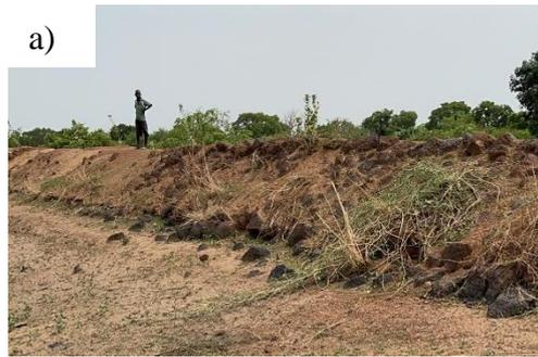
Figure 2 : Digue en terre homogène
