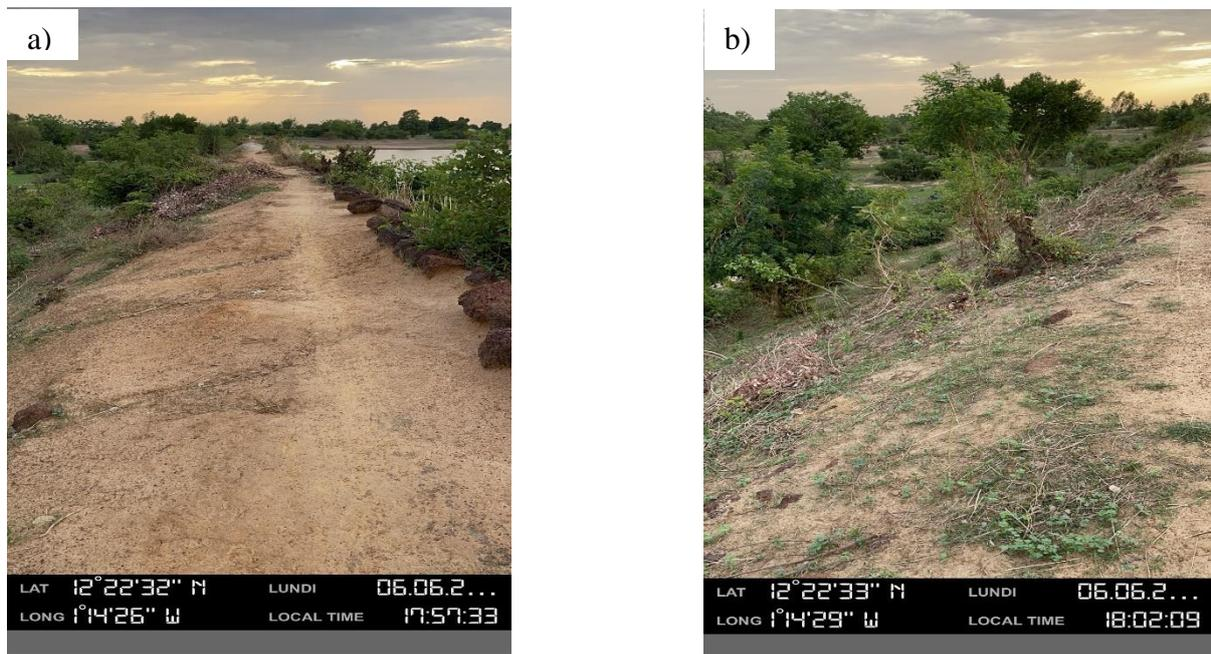
*Figure 9 : a) Erosion de la crête et b) présence de la végétation sur le talus aval*
