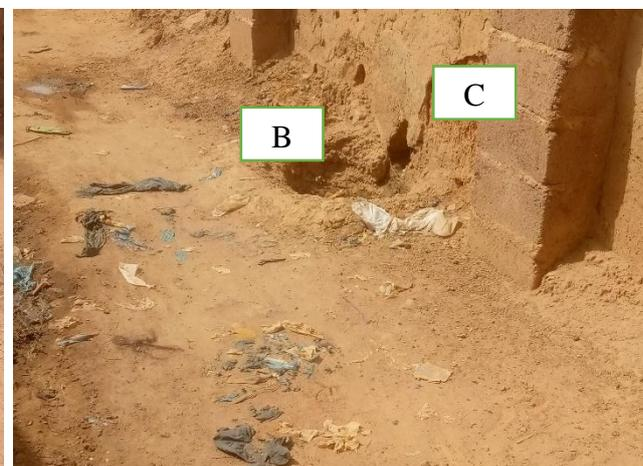
Figure 34: Excavation au pied du mur
