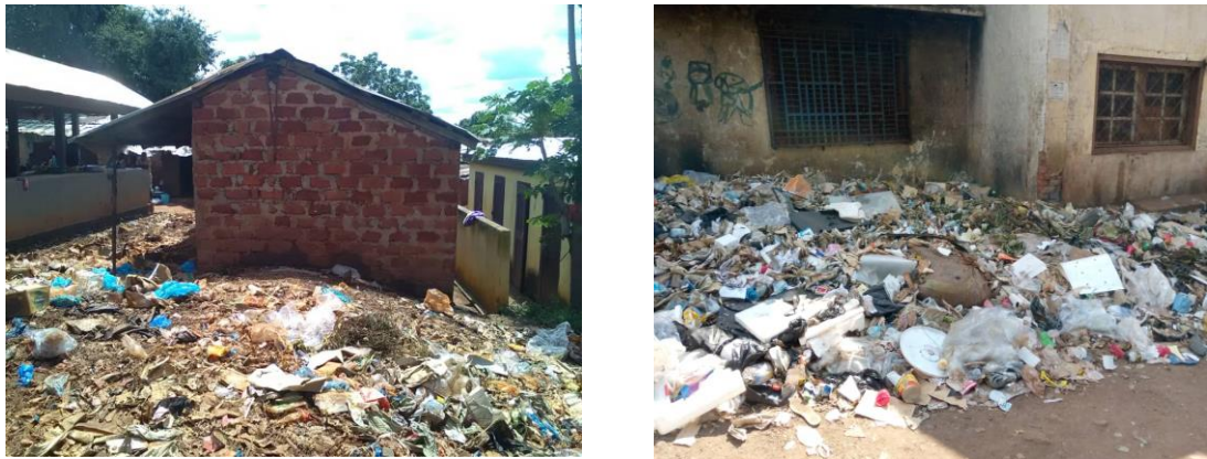
Figure 5 : Bâtiments abandonnés et servant de dépotoir sauvage dans le 3 e Arr. Source : Images terrain, Aout 2021.
