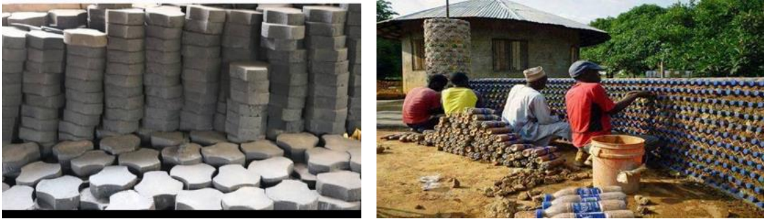
Figure 9 : Exemple de Pavés et de maisons construits à base des bouteilles plastiques
