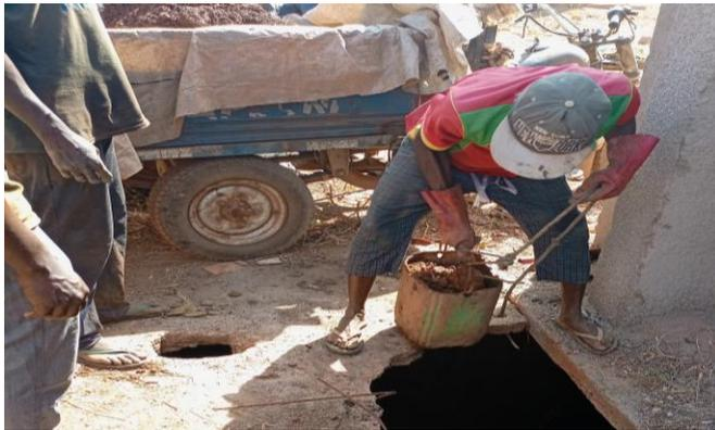
Figure 18 : Equipements de vidangeur lors d'une opération de vidange de boues séchées
