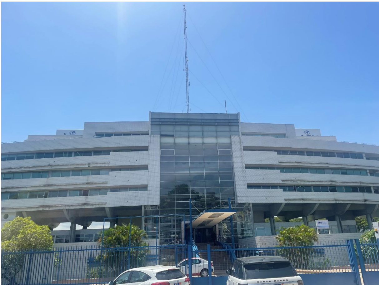
Figure 8 : façade nord du siège d'AGL CI 20
