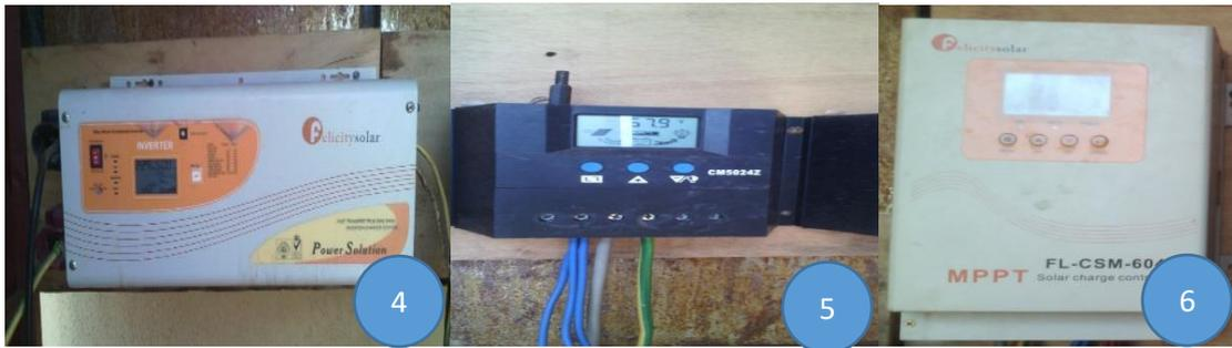
**Figure 5** : Dispositifs installés (panneaux : 1-2, batteries : 3, Convertisseur : 4, régulateurs : 5-6)
