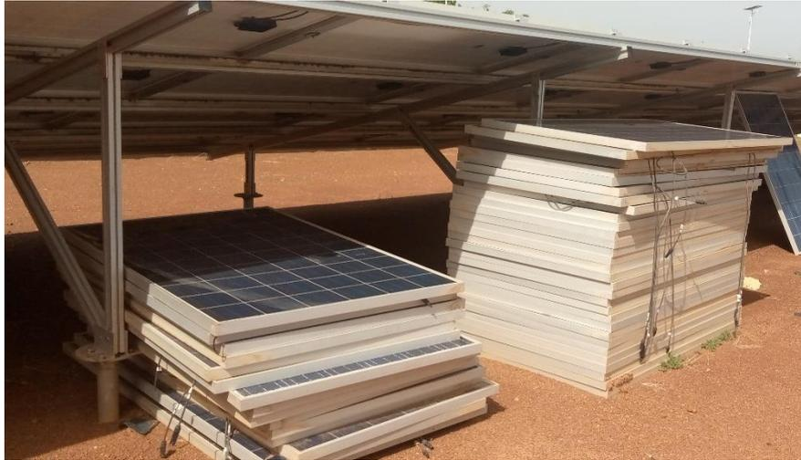
*Figure 4. 2 Stockage des modules hors service à l'air libre*
