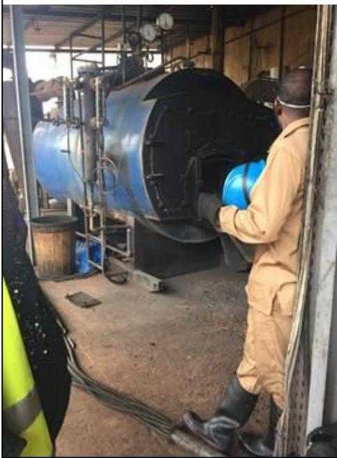
a) Chaudière d'ANATRANS, combustion directe des coques d'anacarde pour la production de chaleur
