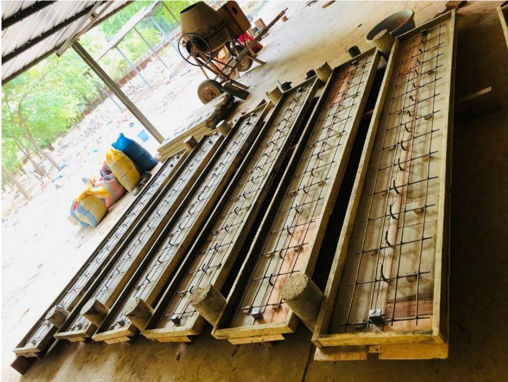
Figure IV- 2: coffrage des poutres et armatures avant coulage de béton
