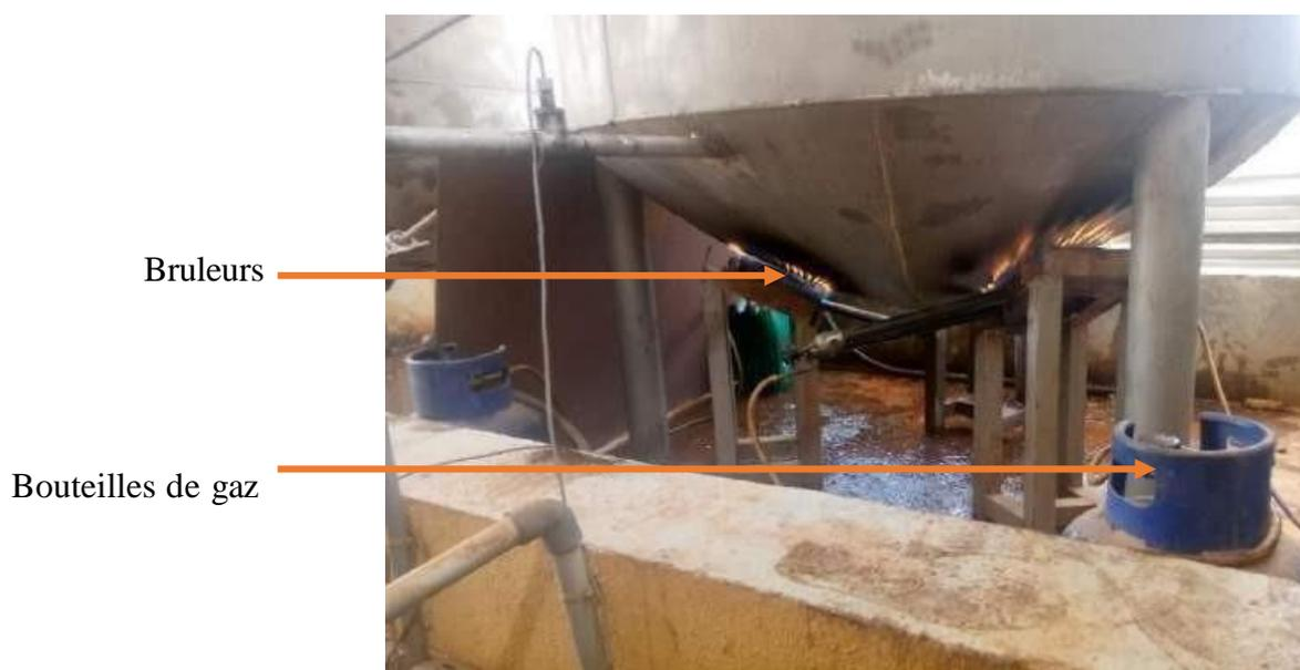
Figure 17: Disposition des bouteilles de gaz et des brûleurs
