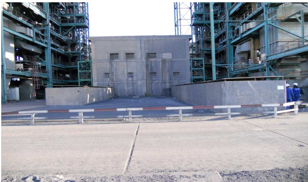
Photo 6 : Une vue du « bâtiment électrique »
