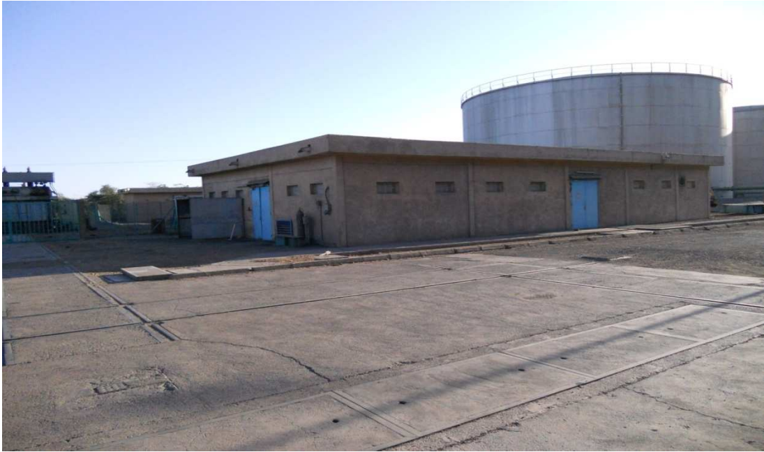
Photo 3: Une vue du bâtiment « poste 20kV »
