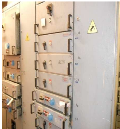
Photo 4: une vue d'une salle MNS
