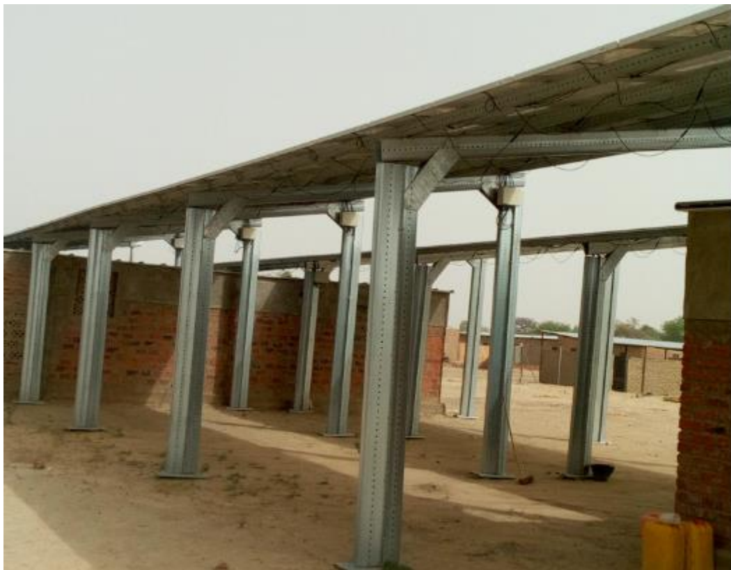
Figure 7:: Des panneaux installés en hauteur sur des châssis
