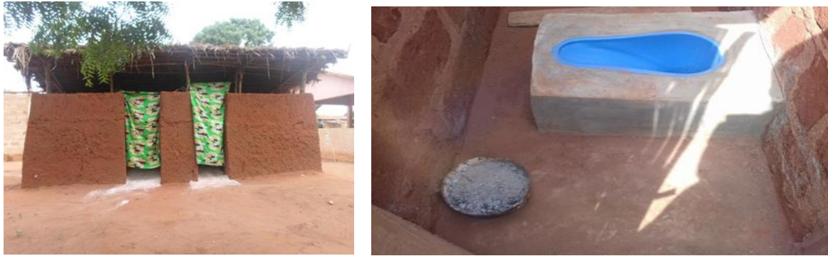
Figure 11 Latrine simple avec dalle en bois (a) et latrine avec dalle en béton (b)
