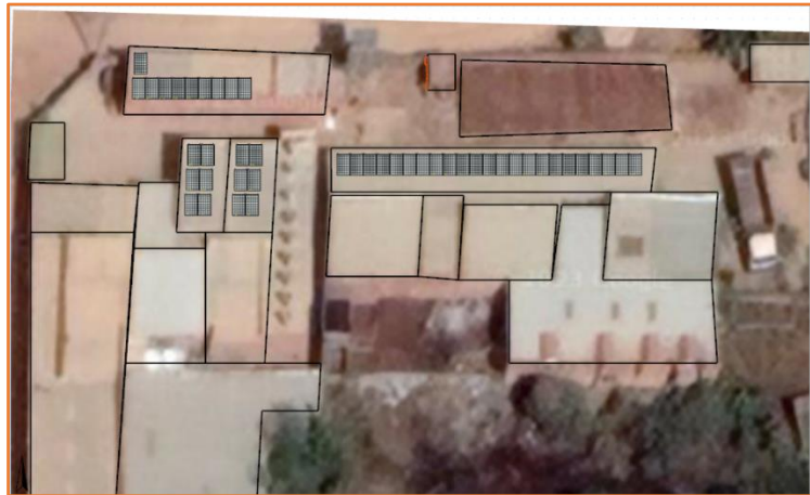
Figure 13: Vue aérienne et disposition des panneaux sur les toits de la PME
