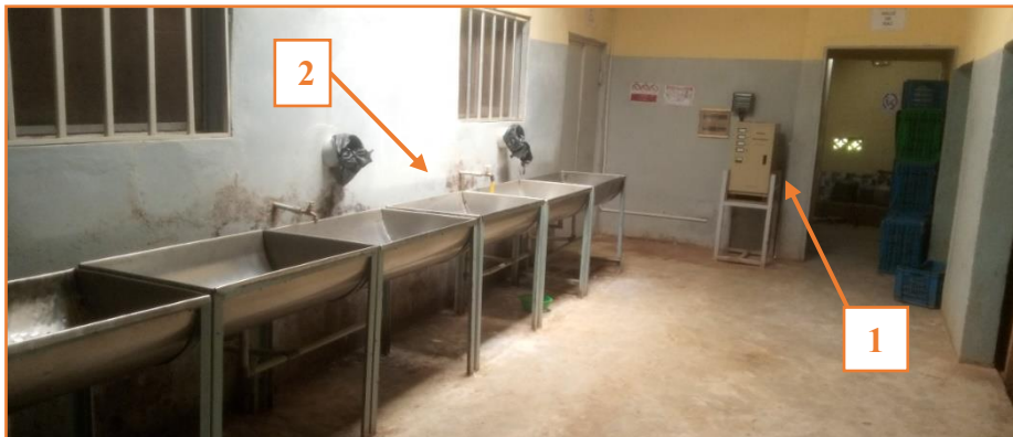
Proximité du régulateur de tension [1] de la zone de lavage [2] de mangues fraîches
