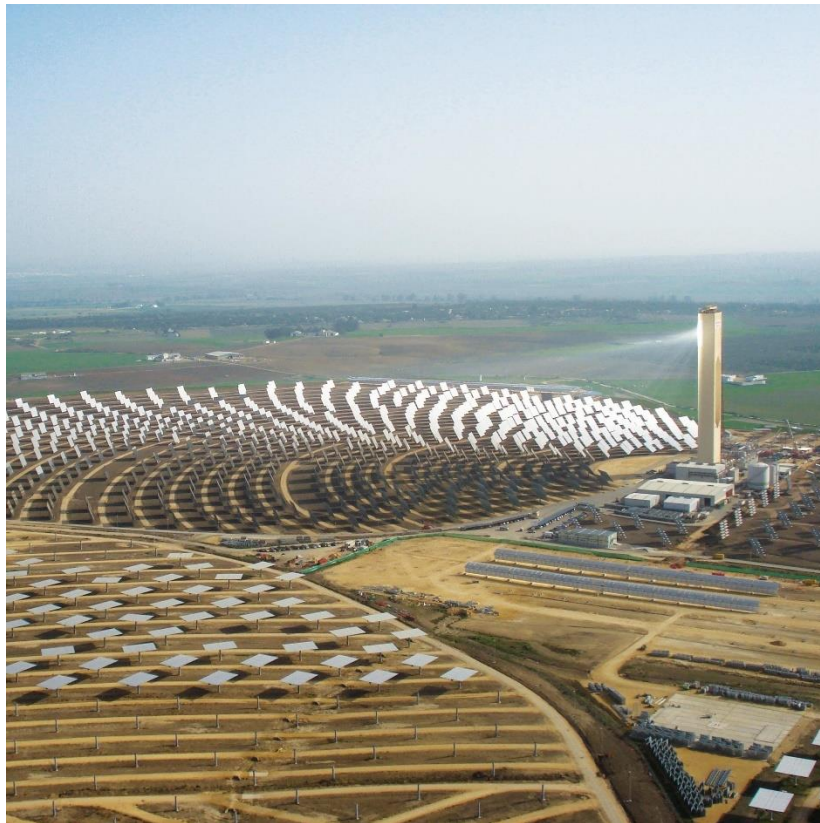
Figure 1. Centrale à concentration PS10 en Espagne[3]
