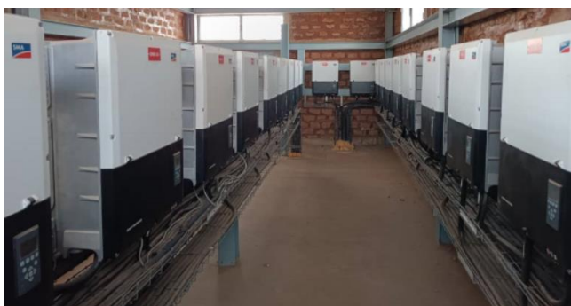
Figure 10: Onduleurs installés
