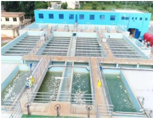
Photo 6: Filière de traitement
