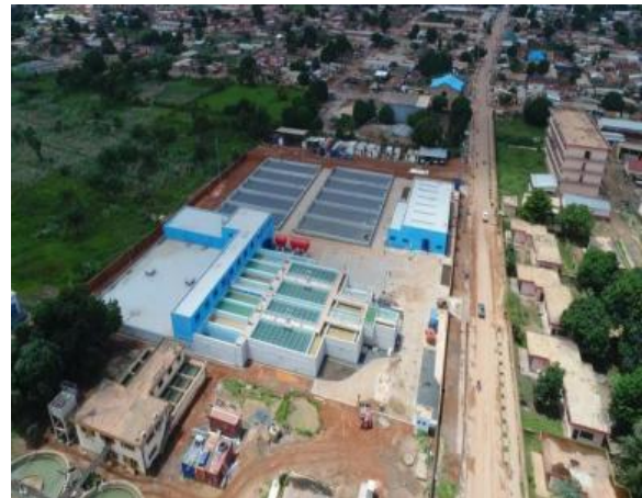
Photo 7: Usine de traitement d'eau
