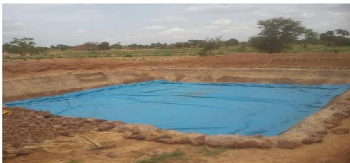
**Figure 5 : Bassin à fond bâche et paroi imperméabilisée en ciment dans le village de Sologon province de Yantenga en zone sahéenne (Zongo, 2012).**
