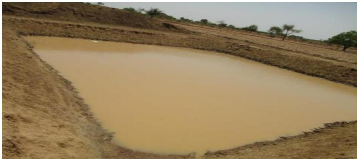
**Figure 2: Bassin à fond non imperméabilisés sur un sol argileux dans le village de Sandouré province de Bam en zone sahéenne Zongo, (2012)**
