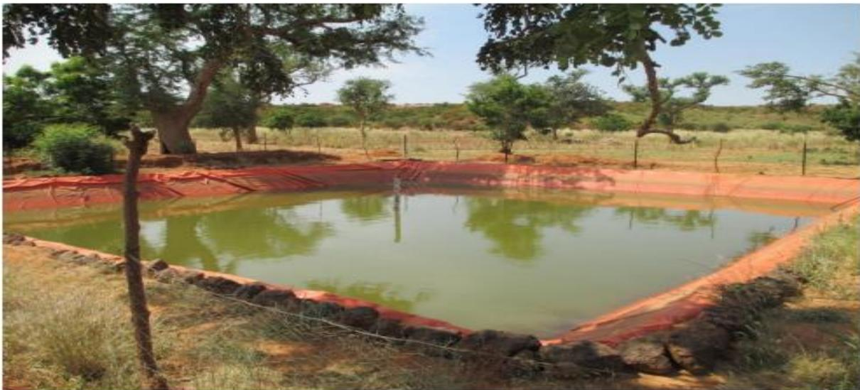
**Figure 6: bassin à paroi et paroi imperméabilisée à partir d'une bâche sur un sol sableux dans le village de Mogodin province du Bam en zone sahéenne Zongo, (2012)**
