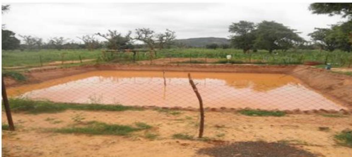
**Figure 4 : Bassin à fond imperméabilisé en argile et paroi imperméabilisé en ciment dans le village de Modogin, province du Bam en zone sahéenne (Zongo, 2012).**
