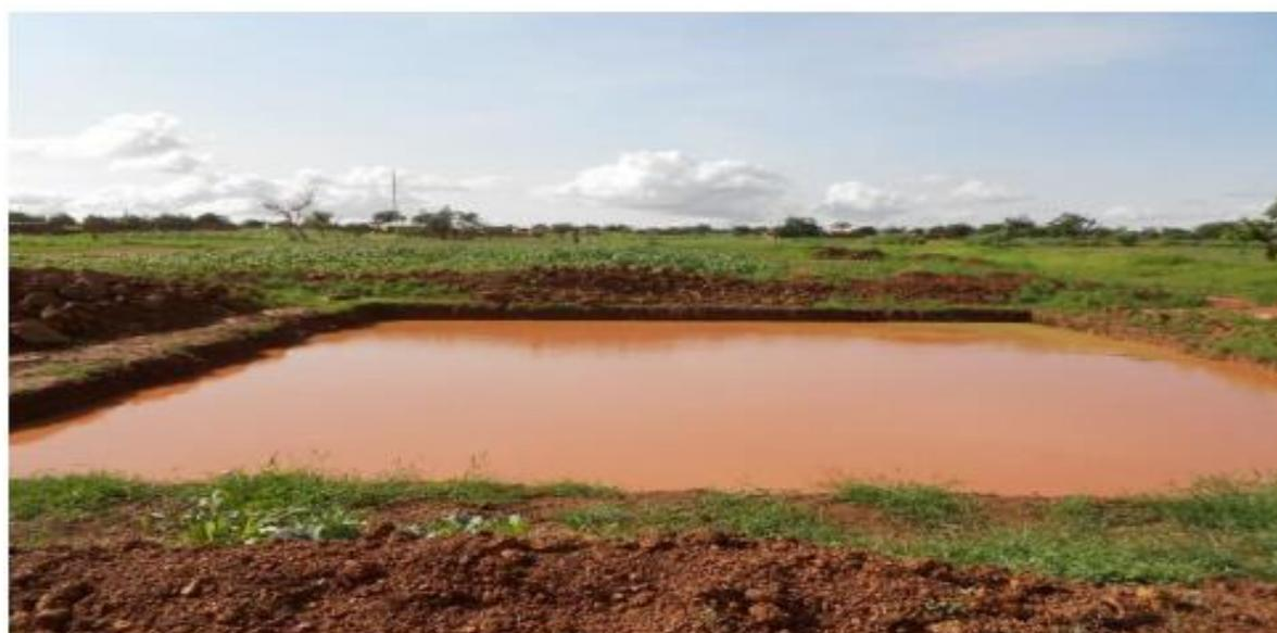
**Figure 3 : Bassin à fond et paroi non imperméabilisée sur un latérique à Tougou province du Yatenga en zone sahéenne Zongo, (2012)**
