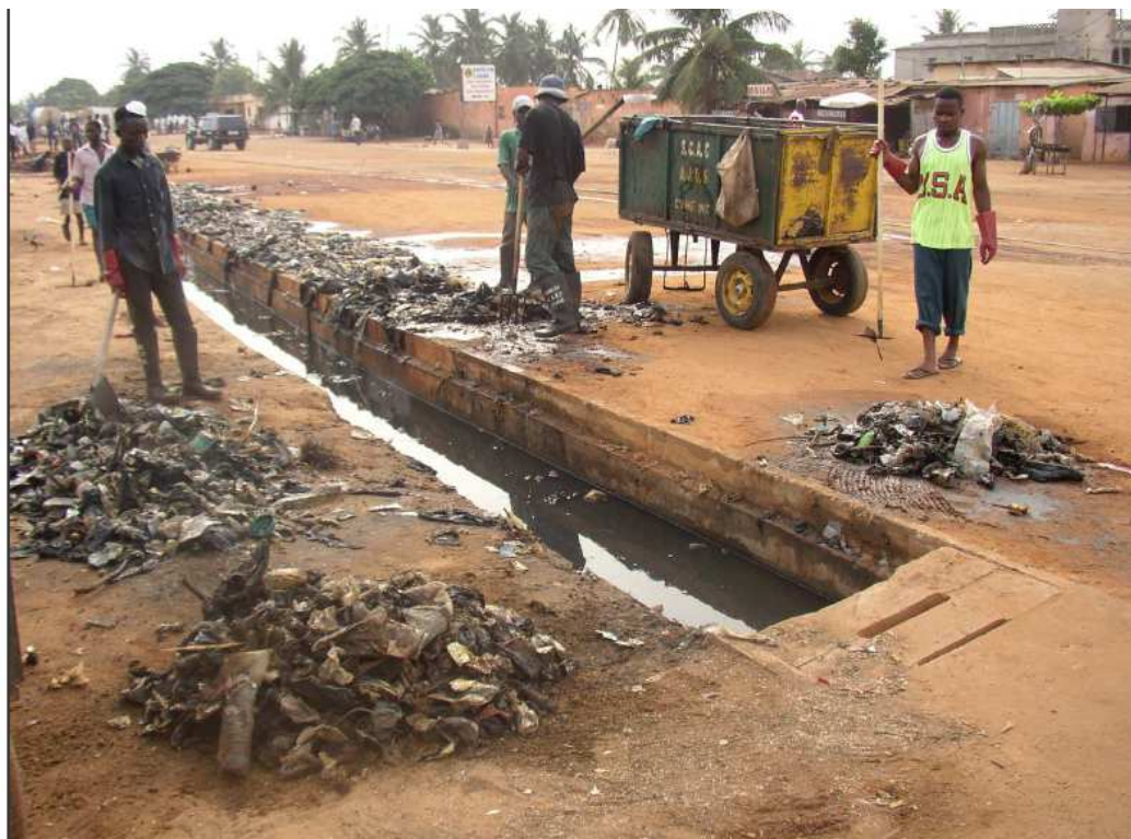
Nettoyage et curage des caniveaux par les associations locales (quartier de Bè Kpota)
