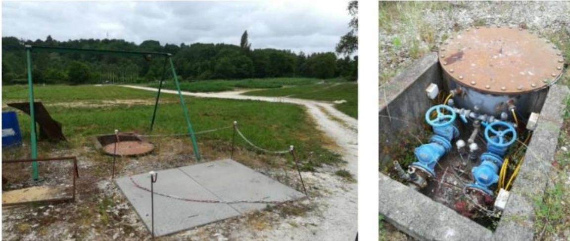
Figure 6: Vue de la cuve sous vide et du départ du refoulement des eaux usées
