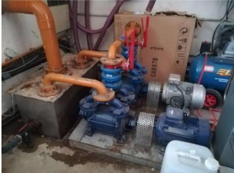
Figure 7: Photographie des pompes à vide existantes et de la cuve à eau associée
