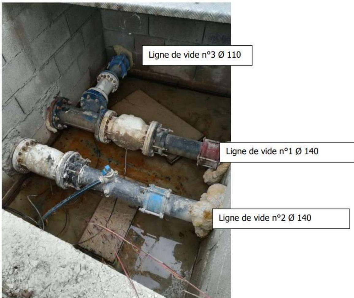
*Figure 5: Vue du regard d'arrivée des 3 lignes de vide au niveau de la station sous vide*
