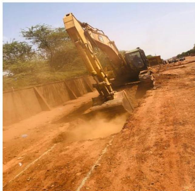
*Image 7 : Béton de propreté pour caniveaux / Travaux de fouilles pour caniveaux*
