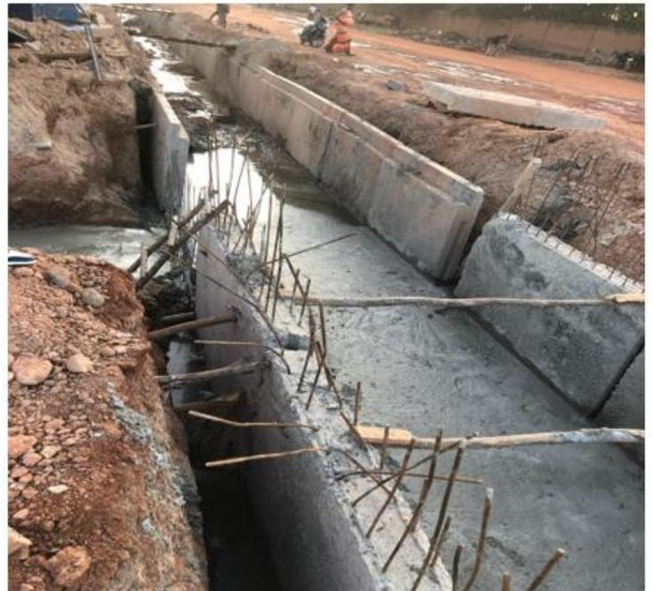
*Image 8 : Ferrailage du tablier d'un dalot / Attentes pour le ferrailage du tablier d'un dalot*
