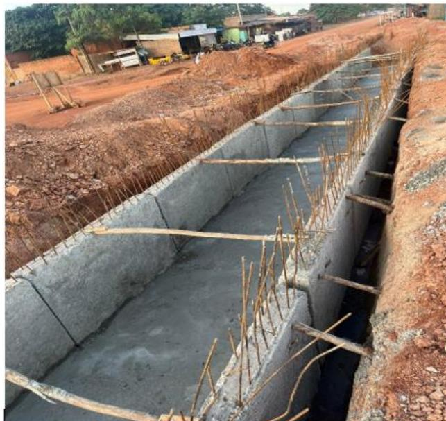
*Image 6 : Travaux de coulage de béton de radier*
