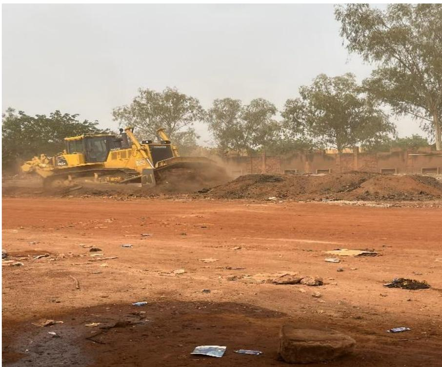
*Image 3 : Décapage à l'aide d'un bulldozer*
