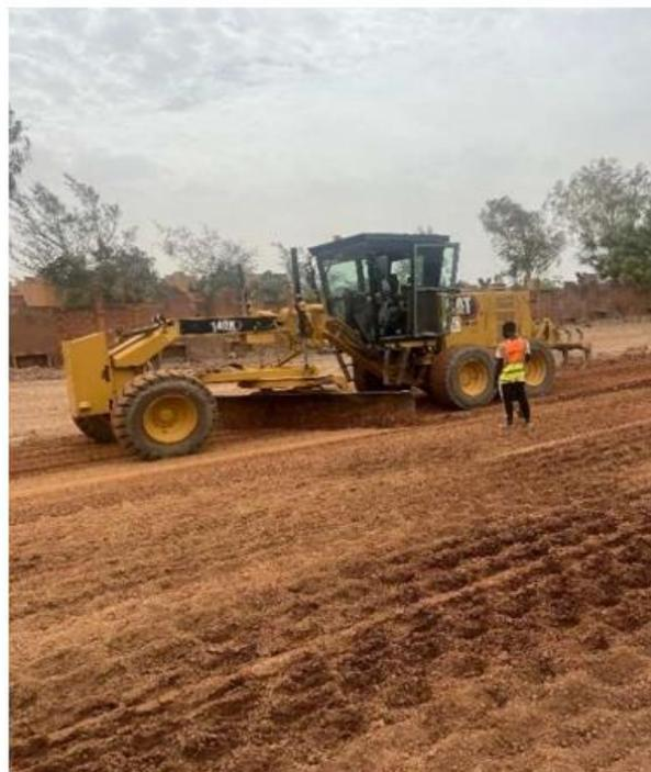
*Image 5 : Travaux de malaxage et de nivellement*
