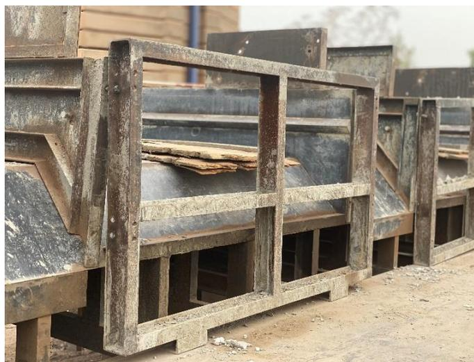
Figure 10: Moules de coffrage des piédroits
