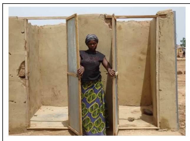
Photo 7 : Latrine VIP inachevée.
