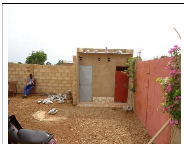
Photo 6 : Latrine VIP achevée
