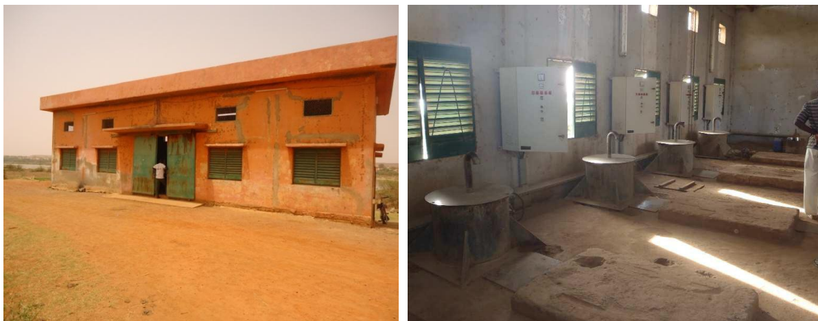
Photos 1: Local abritant la station de pompage principale
