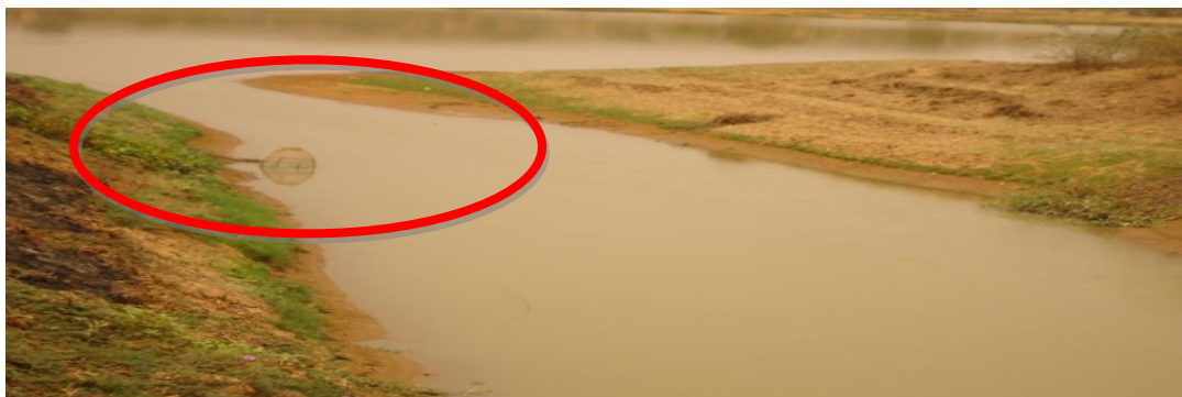
Photo 2 : Chenal d'amenée ensablé au niveau de la prise du fleuve
