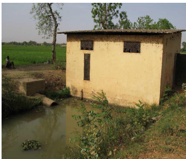
Photo 3 a : vue arrière de la station
