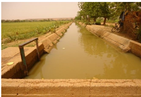
Photo 4 : CP n°2 revêtu
