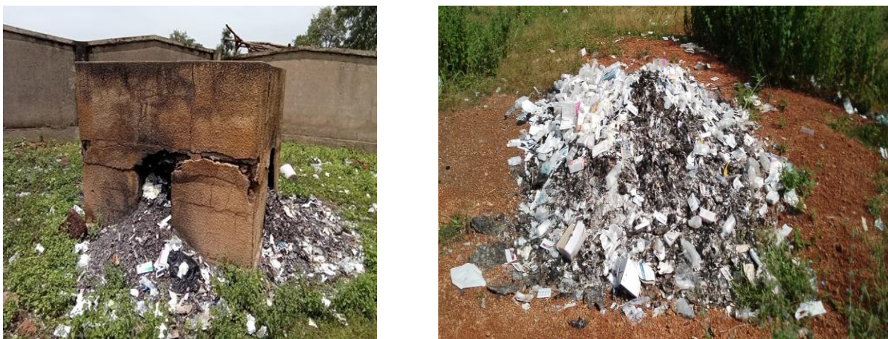
Figure 26: Images d'incinérateurs fissurés, bourrés et non fonctionnels
