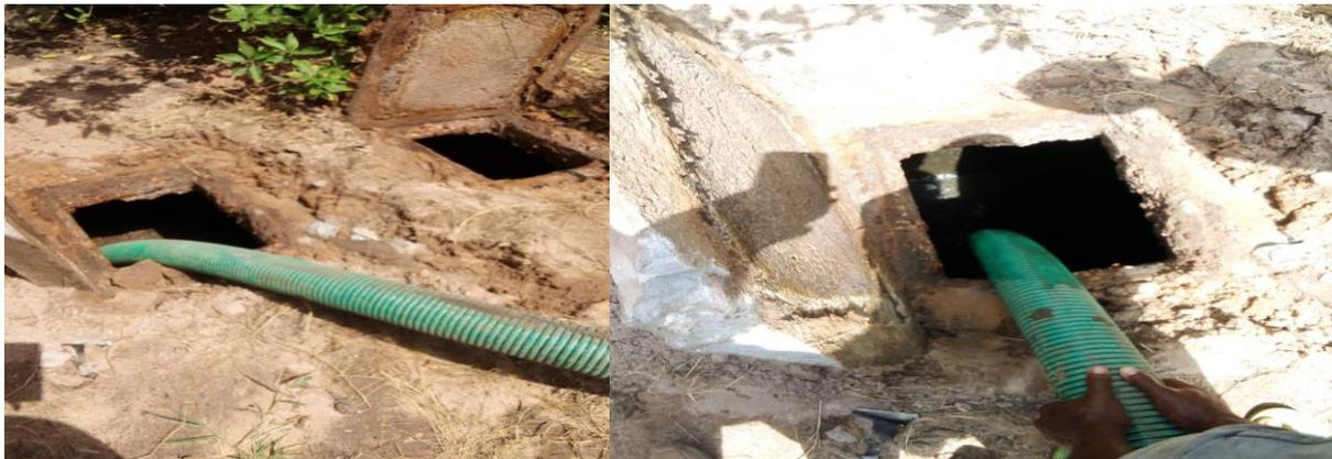
**Figure 11: Opération de vidange mécanique à Adidogomé (sans EPI)**
