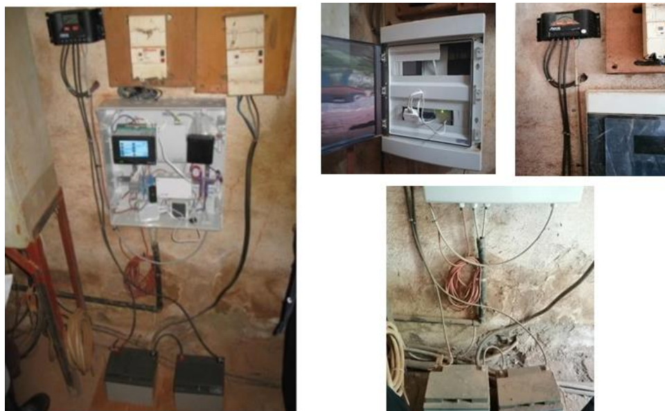
Figure C.15. Le box de collecte des données.
