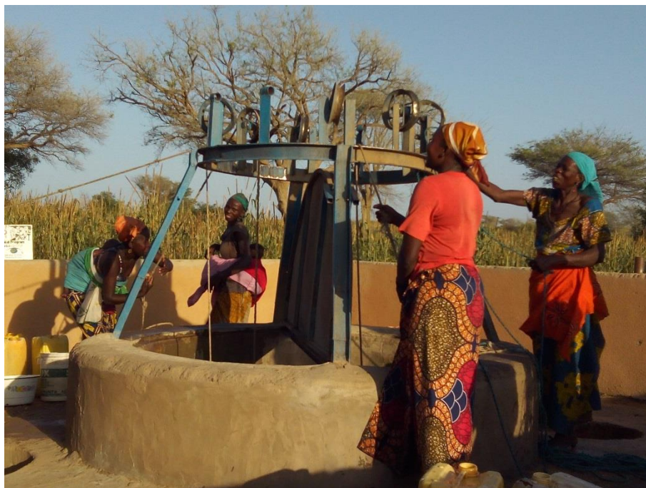
Annexe 2: Puits cimenté réhabilité à Baban Kori
