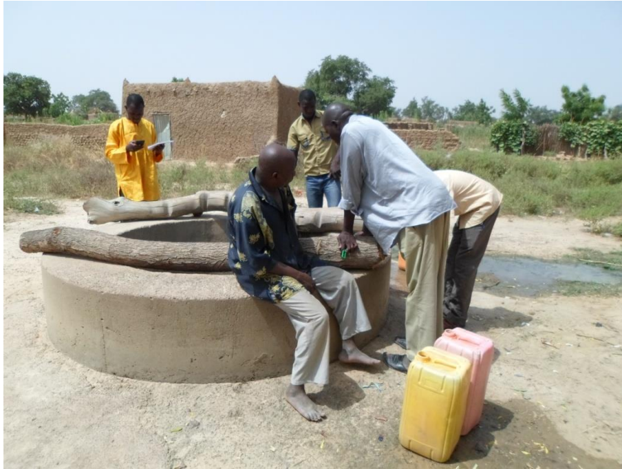
Annexe 1: Puits cimenté de Kataré Moussa avant sa réhabilitation
