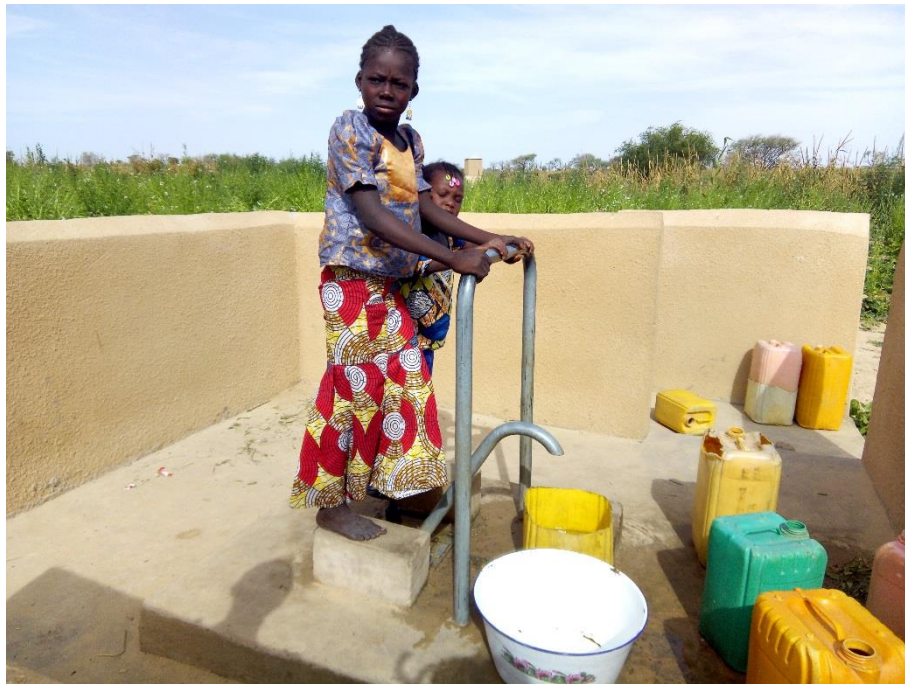
Annexe 3: Forage PMH réalisé au sein du CSI de Dan Dassey
