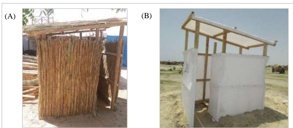
Figure 7: Latrine d'urgence: superstructures en matériaux locaux (A) et modernes (B)
