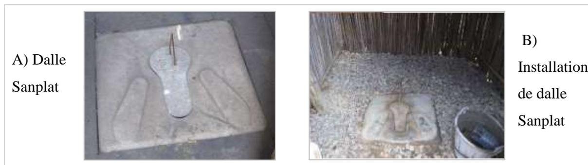
Figure 5: Modèle de dalle de latrine type Sanplat
