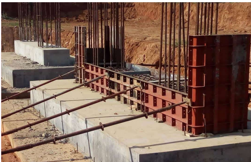
Figure 11 : Aperçu des semelles de la culée C1 coulées
