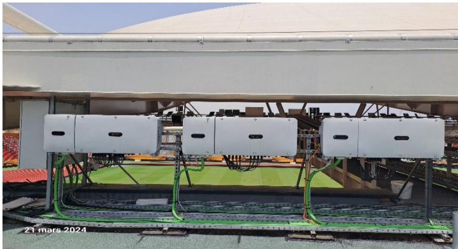
Figure 6: les onduleurs réseaux
