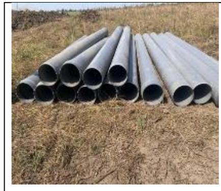
Figure 14 : Les tuyaux tertiaire de diametre 400 mm
