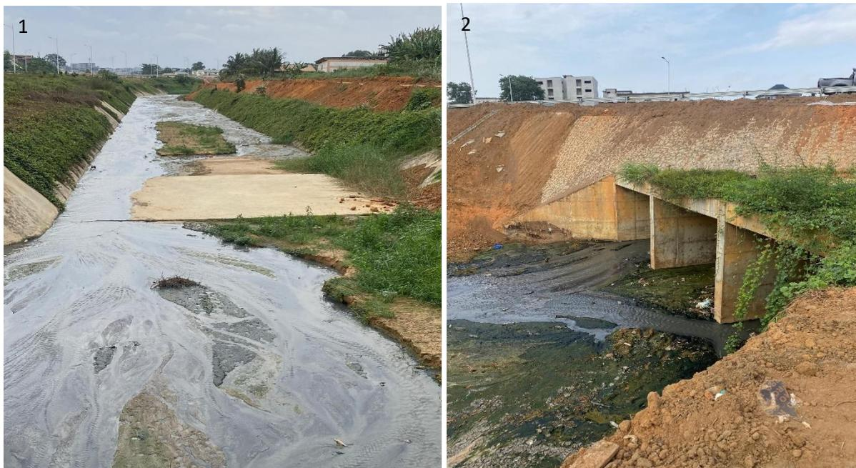
Figure 10 : Canal trapézoïdal (1) et dalot (2). (Fayama W R A, 10 juin 2024)
