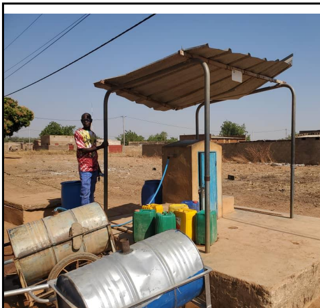
Image 2 : Toiture dégradée au niveau de la BF3 et plateforme d'accès haute
