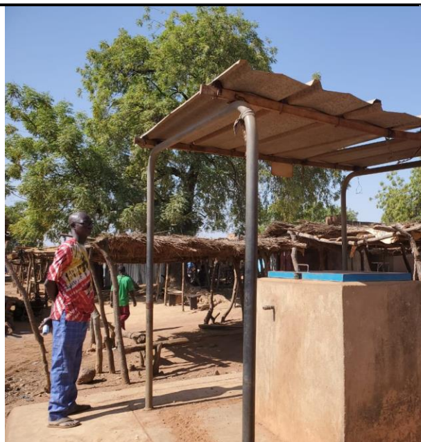
Image 3 : Toiture dégradée au niveau de la BF10
