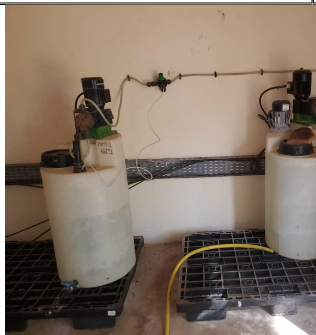
Image 8: Système de chloration type Dosatron fonctionnel
