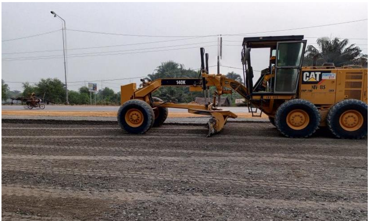
Annexe 4.2 : Malaxage de la couche de GNT crue par la niveleuse
