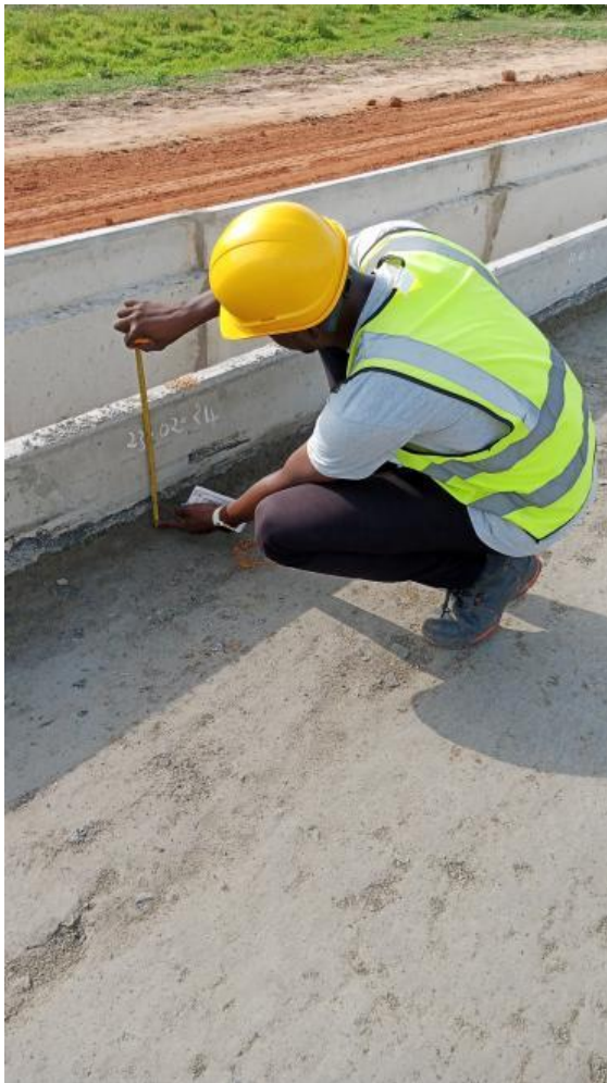
Annexe 4.8 : Contrôle des épaisseurs de chaussées exécutées
