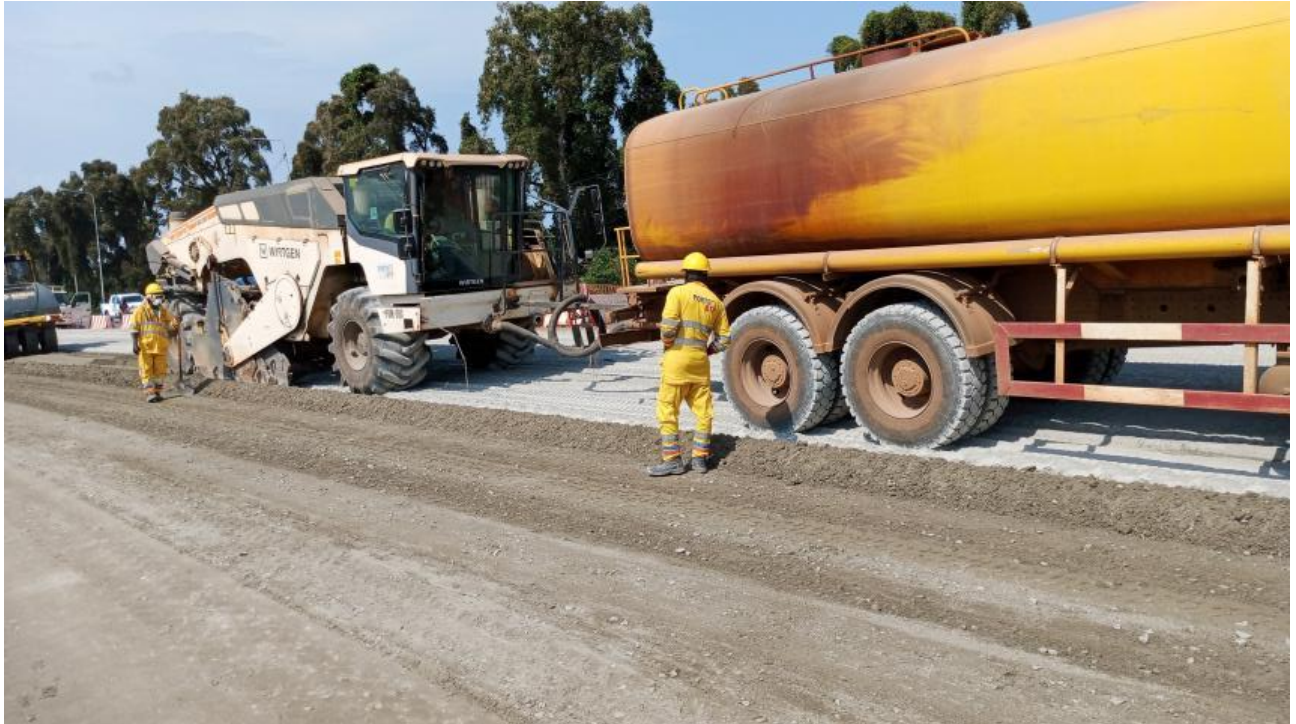
Annexe 4.5 : Malaxage du matériau traité au ciment à l'aide d'une recycleuse
