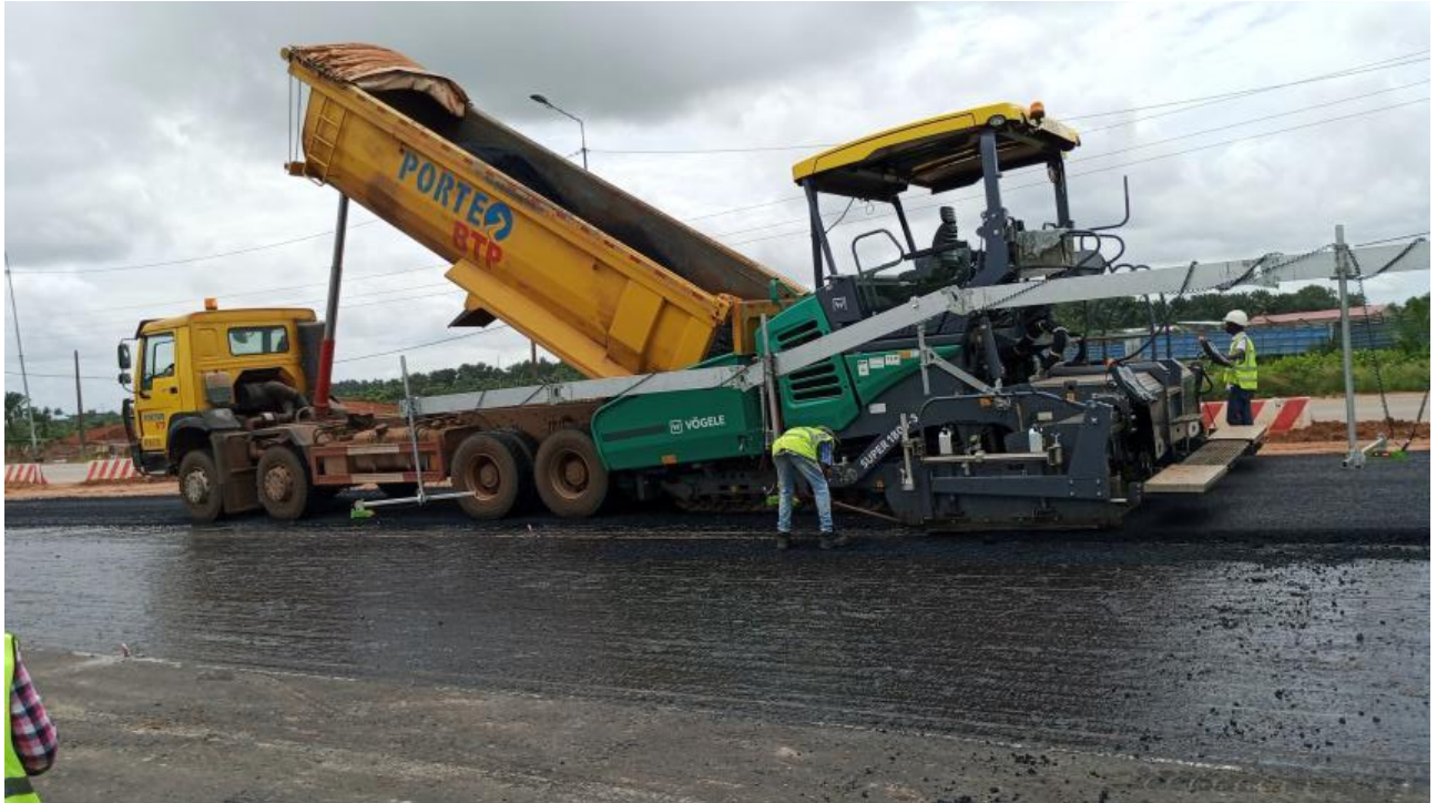
Annexe 4.7 : Mise en œuvre de la couche de GB
