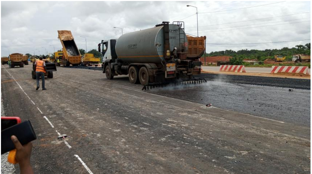
Annexe 4.6 : Application de l'émulsion
