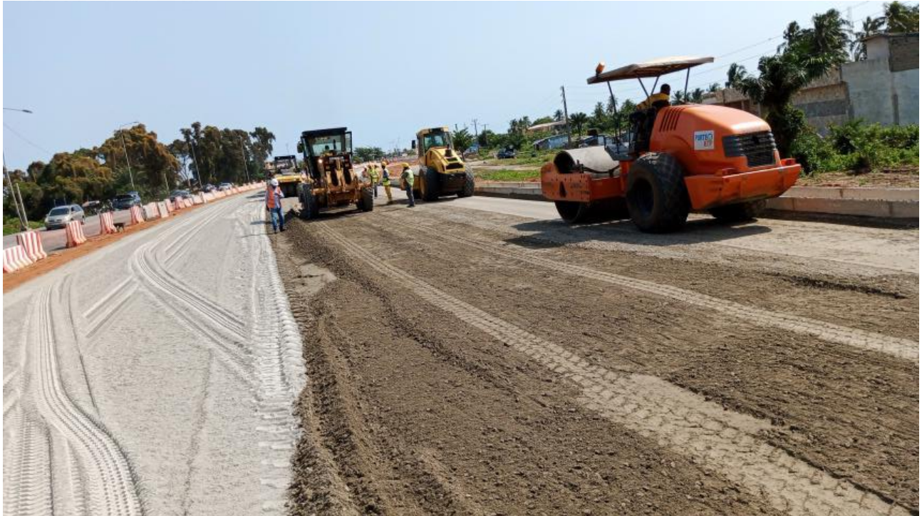
Annexe 4.3 : Mise en œuvre de la couche de GNT améliorée au ciment
