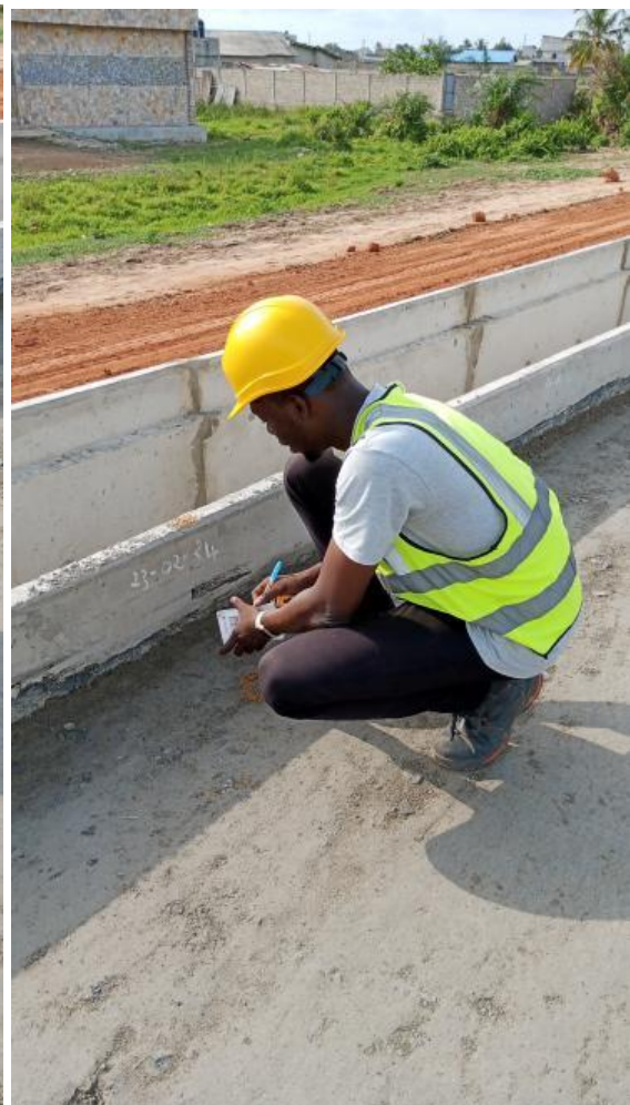
Annexe 4.8 : Contrôle des épaisseurs de chaussées exécutées
