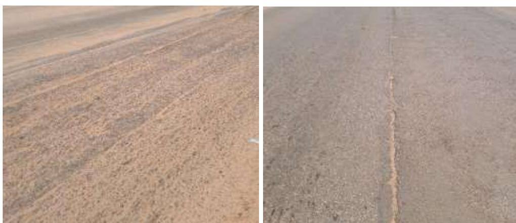
*Figure IV-05 Fissuration longitudinale*
