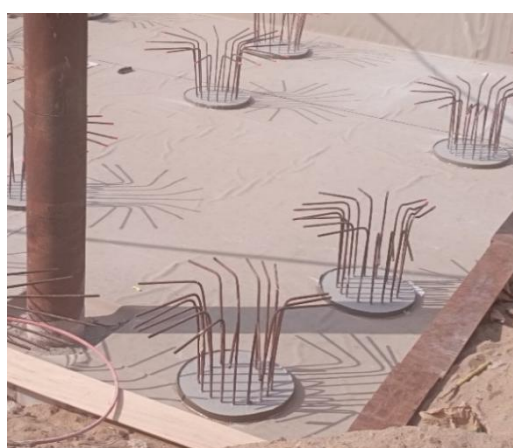
Figure 11: Pose de la membrane sur le BP
