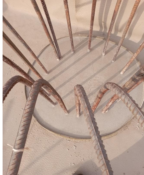
Figure 13: Pose des membranes Sika Waterbar et SikaGrout
