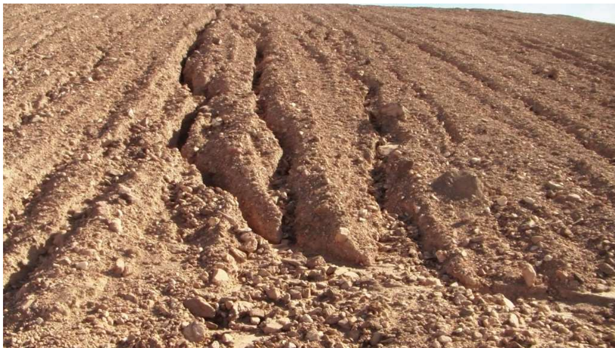
Photo n° 2 : Effets de l'érosion sur le flanc de la halde à stérile.
