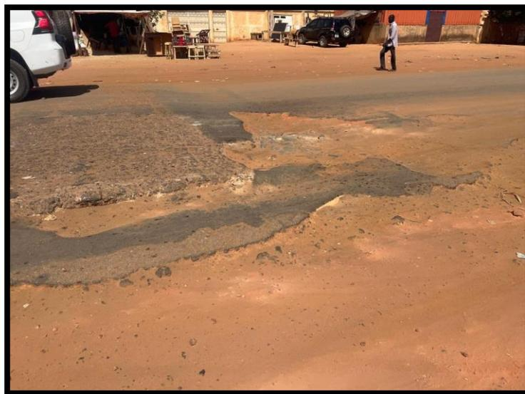
Figure 15: Dégradation de la couche de surface PK4+664
