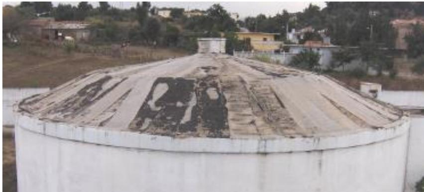
**Figure 24:** Étanchéité détériorée sur la coupole
