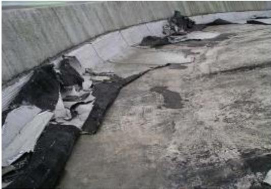
**Figure 25:** Papier Kraft détérioré sur la couverture du réservoir
