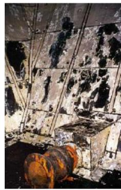
**Figure 26:** Enduit de mortier à l'intérieur du réservoir (Classe A)
