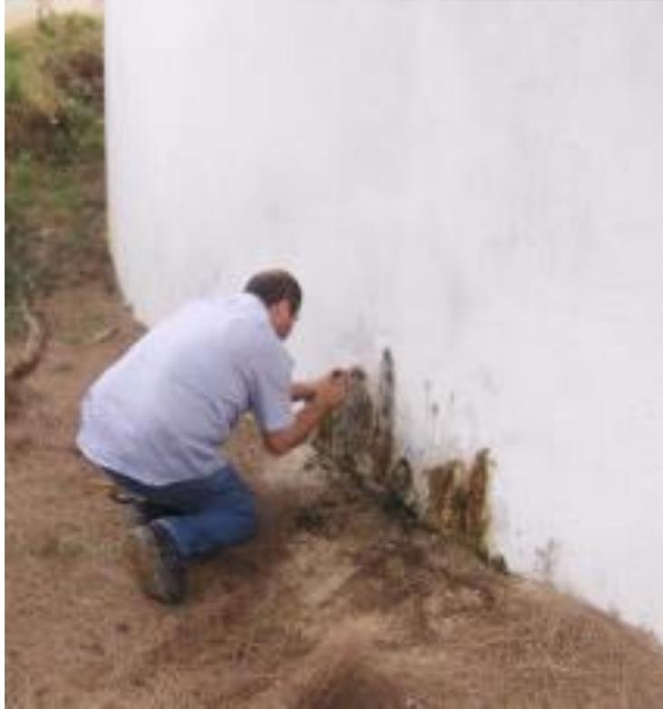
**Figure 22:** Suintement des parois extérieures du réservoir de Haddada
