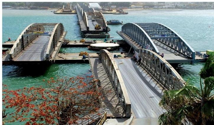
*Figure II-12. Ponts en treillis Bow-string*
