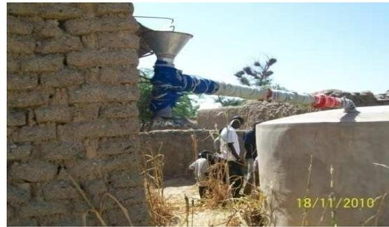
**Figure 15** : filtre endommagé au niveau de l'entonnoir
