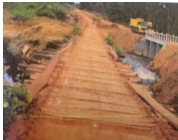
Figure 18: Construction d'un dalot 3×3×3,5 à 7km de Danané en cours
