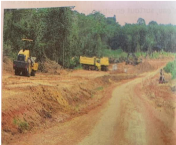
Figure 16: Travaux de reprofilage lourd en cours sur l'axe Danané-Gbeunta
