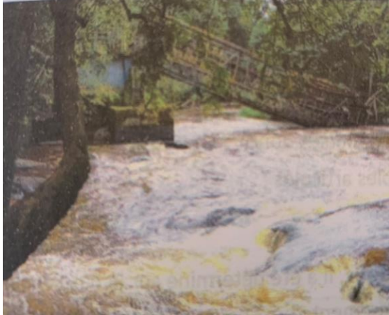
Figure 20: Vestige du 1er pont métallique de franchissement du Nuon à la frontière de la Côte d'Ivoire
