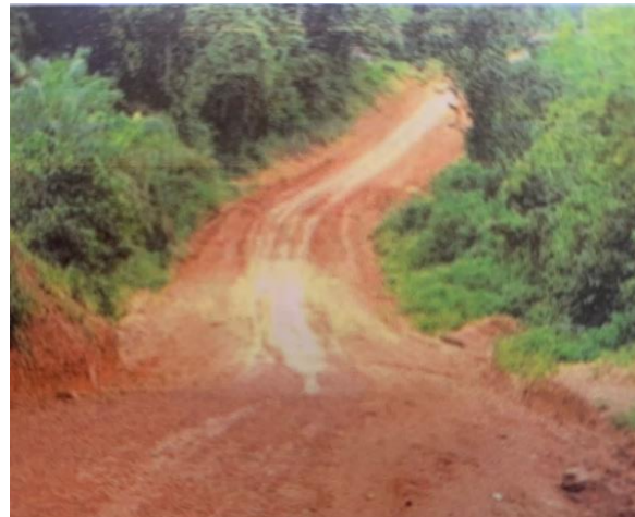
Figure 15: Vue d'une pente dangereuse avec des zones accidentogènes sur le tracé de la voie actuelle
