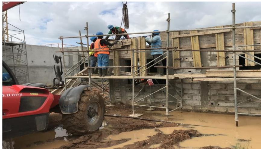
Fixation des panneaux de coffrage à l'aide du manitou (Photo2 : BSM)
