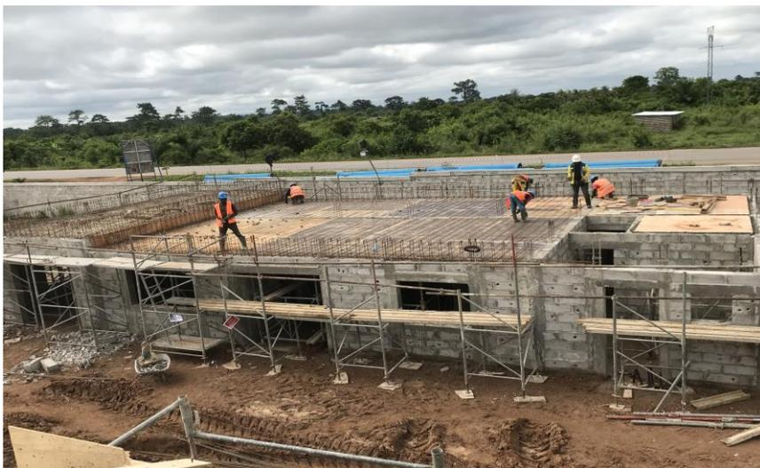
Ligaturage du plan de ferrailage d'une dalle (Photo7 : BSM)
