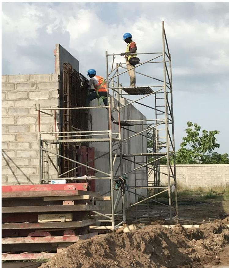
Travaux de ferrailage d'une voile (Photo5 : BSM)
