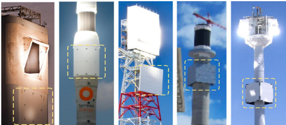
Figure 27: Illustration des cibles de calibration placées sous le récepteur dans différentes centrales CSP (de gauche à droite) : Planta Solar 10, Gemasolar, Coalinga Chevron Solar, Crescent Dunes Solar power plant, Sierra Suntower [89].
