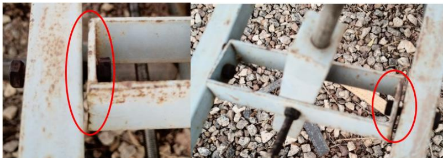
Figure 35: Cas de tolérances dimensionnelles des cornières de liaison (encerclées en rouge)
