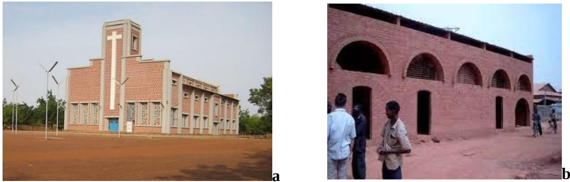
Figure I.3-1: Exemple de structure de maçonnerie en BLT ( a. la cathédrale de Koudougou, b. Ecole primaire A de Koudougou ) [70,71]
