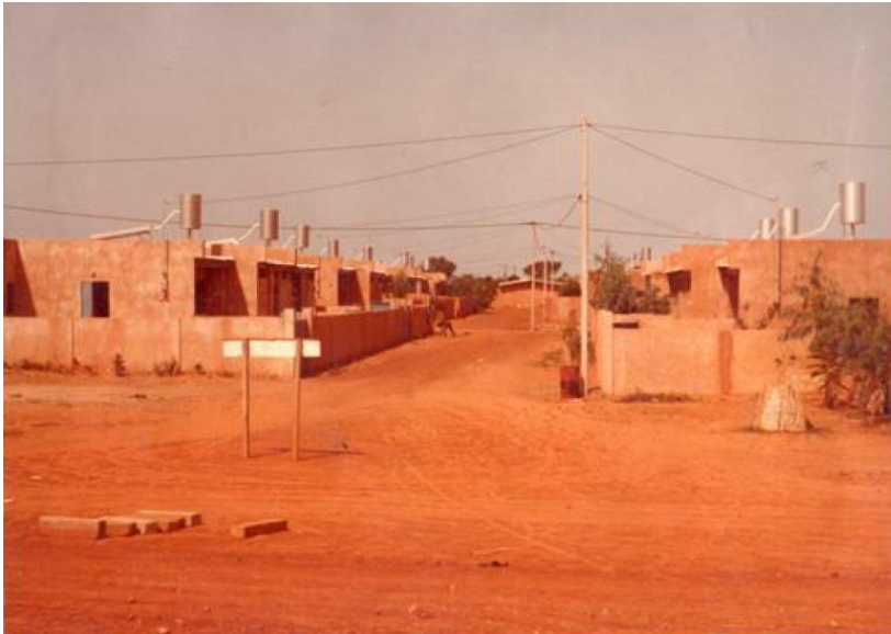
Figure 6. CES de fabrication locale installés dans un lotissement ENAREM à Niamey (Niger) dans les années 1970.
