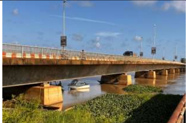
Figure 4: Pont routier actuel construit en 1981
