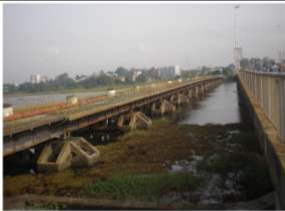
Figure 3: Pont ferroviaire construit en 1956
