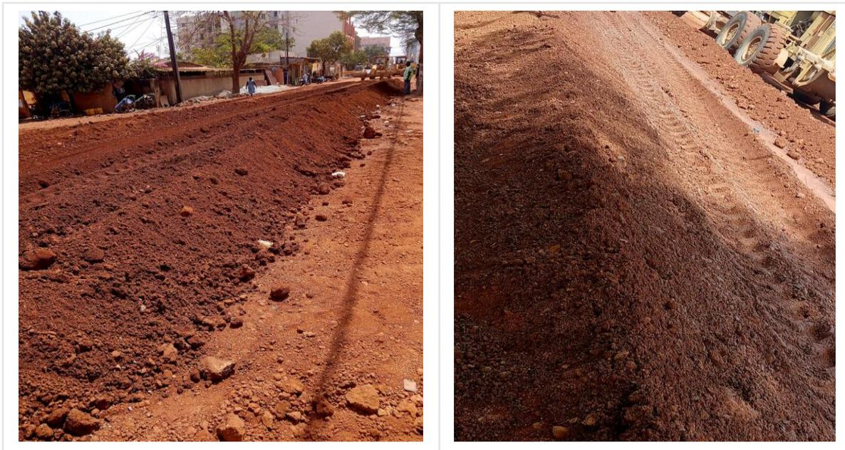
Figure 27: Etalement de la grave latéritique crue
