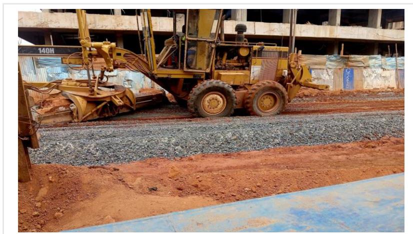
Figure 28: Etalement des concassés de granite sur la grave latéritique crue
