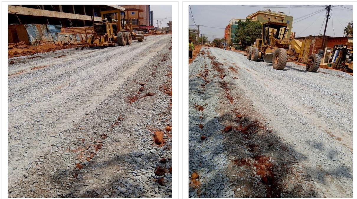
Figure 30: Scarification du mélange par le scarificateur de la niveleuse
